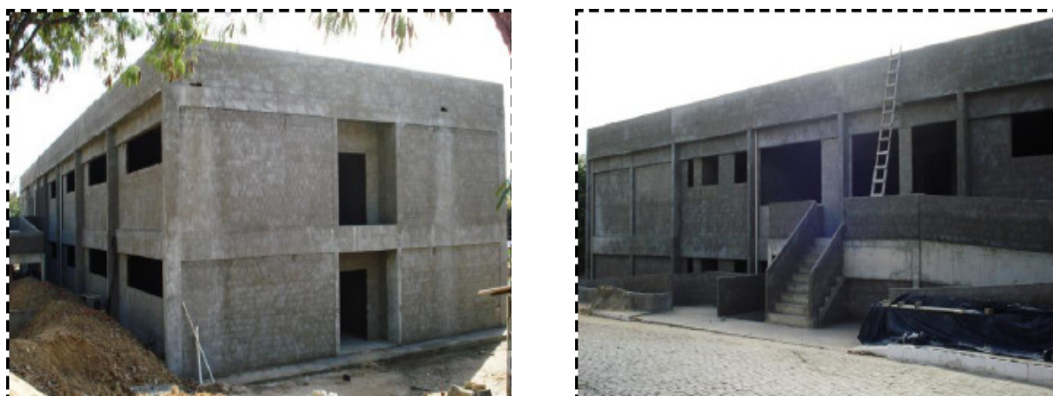
Figura 4. (a): Visão frontal e (b): lateral do novo prédio de aulas do campus de Jequié.
